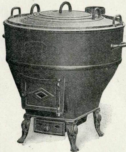
Le foyer à bois peut être transformé en foyer à houille par adjonction de contre-plaques et d'une grille à barres.
