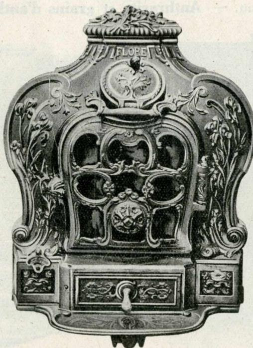
ment d'un masque qui la protège contre les coups de feu et garanti la conservation de l'émail. La porte mica est garnie d'amiante, ce qui assure une fermeture parfaite. La porte du cendrier rigoureusement dressée s'applique sur un gueulard également dressé. Le réglage est ainsi obtenu rigoureusement par l'obturation de l'entrée d'air.
